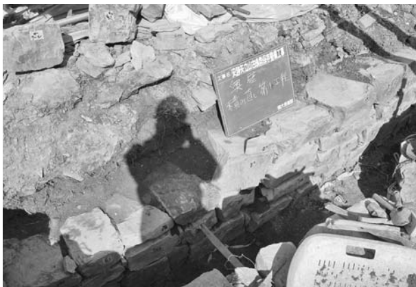
写真75 平成19年度石室修理工 2号墳奥壁積み直し状況④
