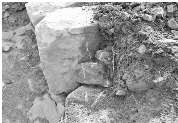
写真109 平成19年度石室修理工 2号墳羨道西側壁解体状況⑭
