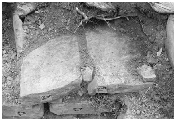
写真103 平成19年度石室修理工 2号墳羨道西側壁解体状況⑧
