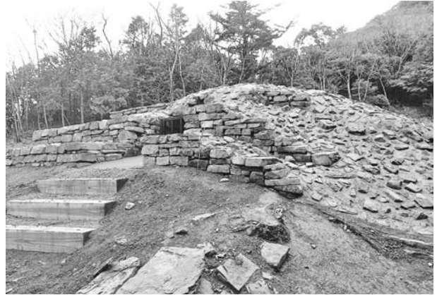
写真406 平成25年度墳丘整備工完成状況①（南東から）
