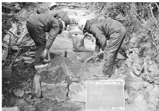
写真438 平成26年度整備工事園路工土舗装施工状況
