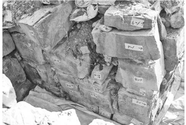
写真136 平成19年度石室修理工 2号墳東前壁施工前状況 (西から)
