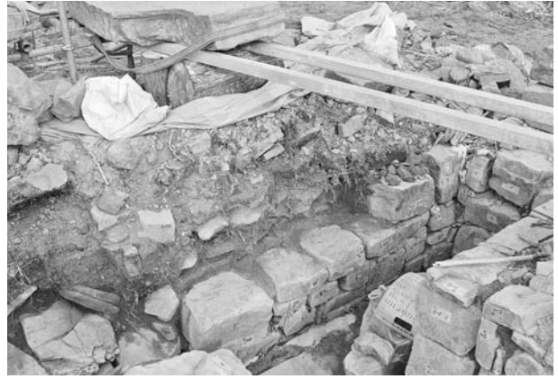
写真62 平成19年度石室修理工 2号墳奥壁解体状況⑧
