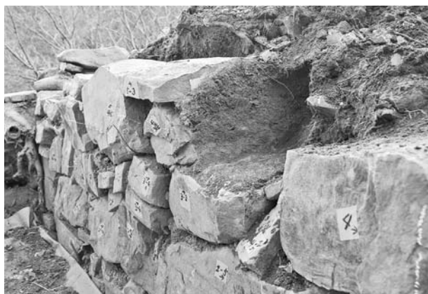
写真111 平成19年度石室修理工 2号墳羨道西側壁解体状況⑯
