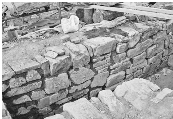
写真88 平成19年度石室修理工 2号墳奥壁積直完了状況② (南から)
