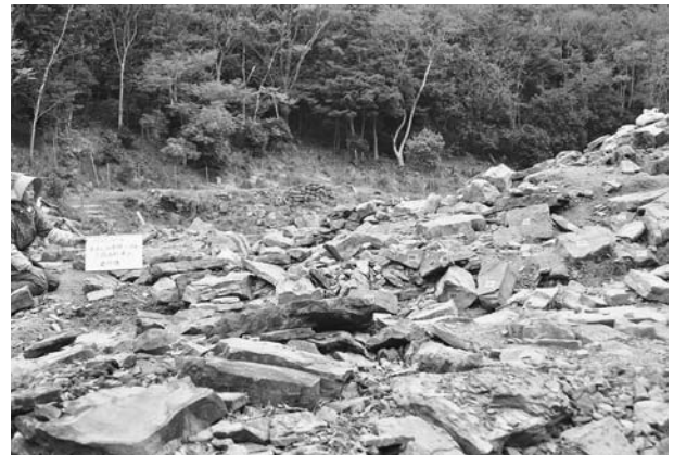
写真344 平成25年度1号墳整備作業下段石列南辺番付け後
