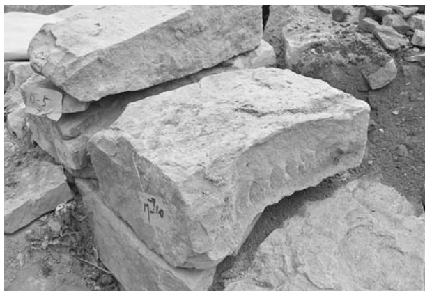
写真121 平成19年度石室修理工 2号墳羨道西側壁解体状況⑥
