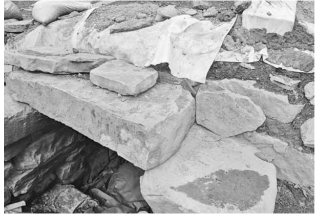
写真390 平成25年度墳丘整備工石室修理完成状況（南東から）
