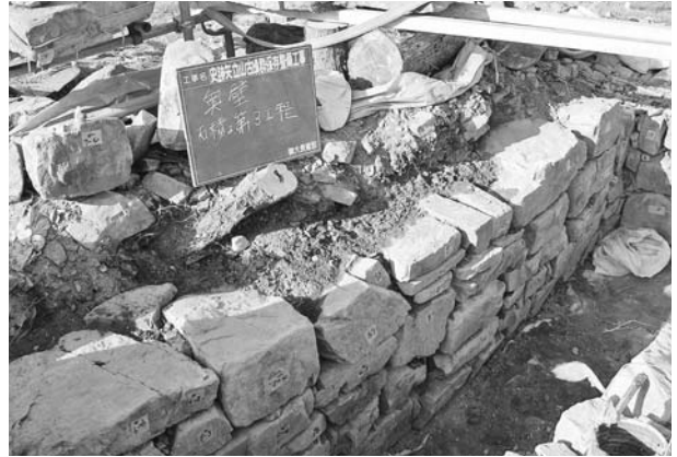
写真78 平成19年度石室修理工2号墳奥壁積み直し状況⑦
