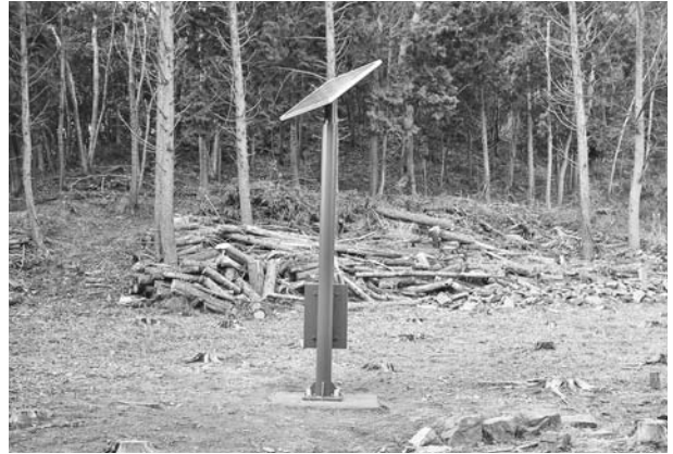
写真270 平成24年度照明施設工ソーラー設備完成状況(南から)
