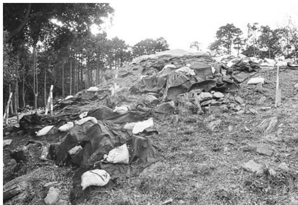
写真373 平成25年度墳丘整備工施工前状況（東から）
