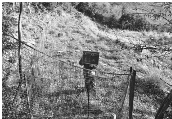
写真224 平成22年度展望広場整備工事施工前状況(南西から)
