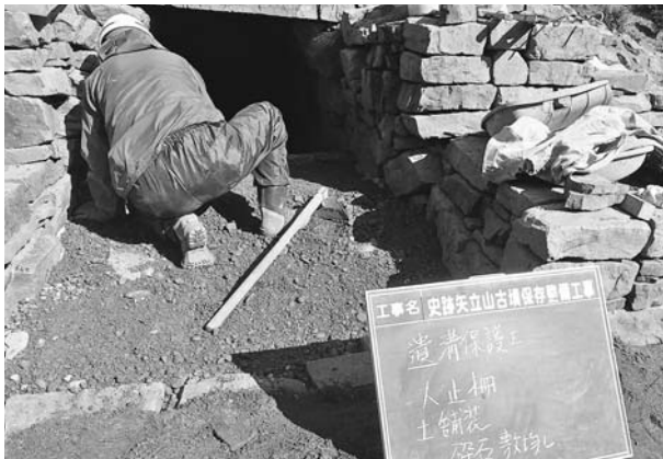
写真399 平成25年度墳丘整備工遺構保護工人止柵土留花砕石敷均し状況（南東から）
