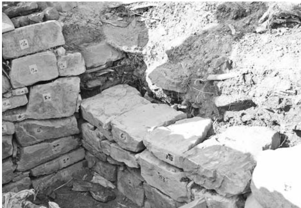
写真73 平成19年度石室修理工 2号墳奥壁積み直し状況②
