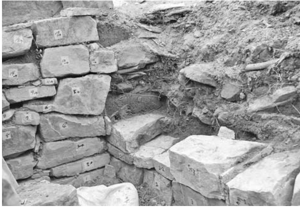
写真69 平成19年度石室修理工 2号墳奥壁解体状況⑮
