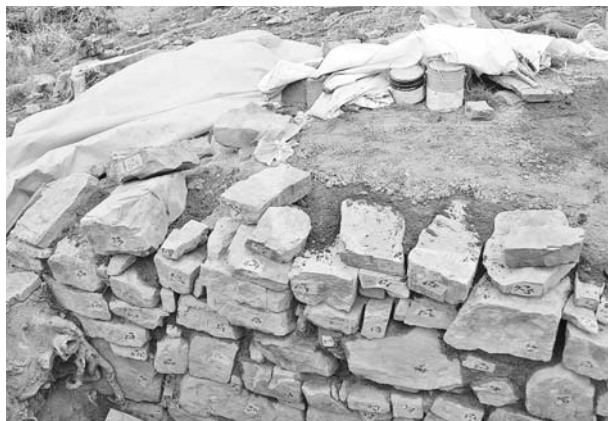
写真125 平成19年度石室修理工 2号墳羨道西側壁積み直し状況③
