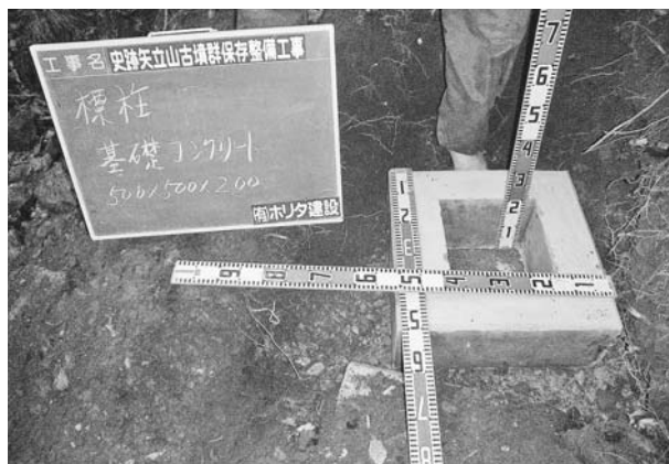
写真430 平成26年度整備工事学習施設工標柱基礎コンクリート
