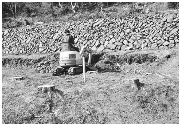
写真38 平成18年度基盤整備工造成工施工状況②
