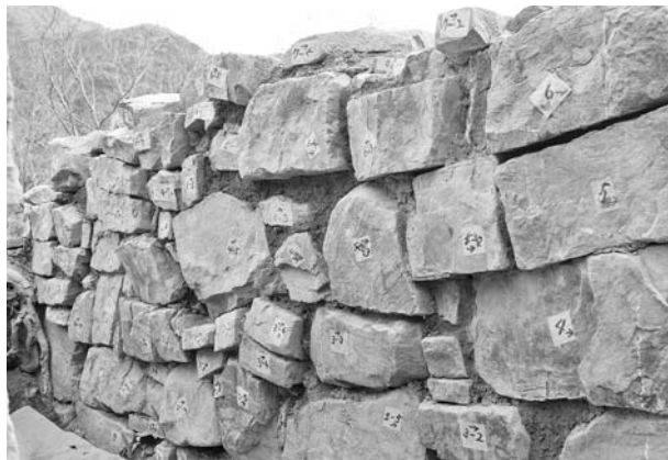
写真129 平成19年度石室修理工 2号墳羨道西側壁積み直し完了状況③ (北から)
