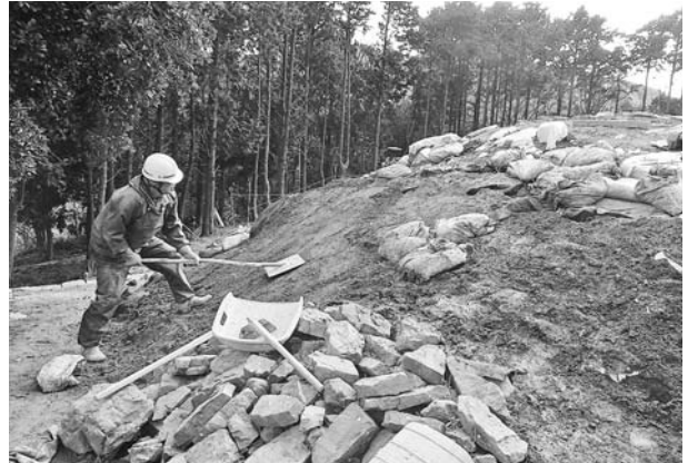
写真392 平成25年度墳丘整備工墳丘盛土盛土転圧状況（北から）
