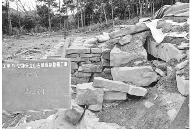
写真384 平成25年度墳丘整備工石室修理施工前状況(東から)
