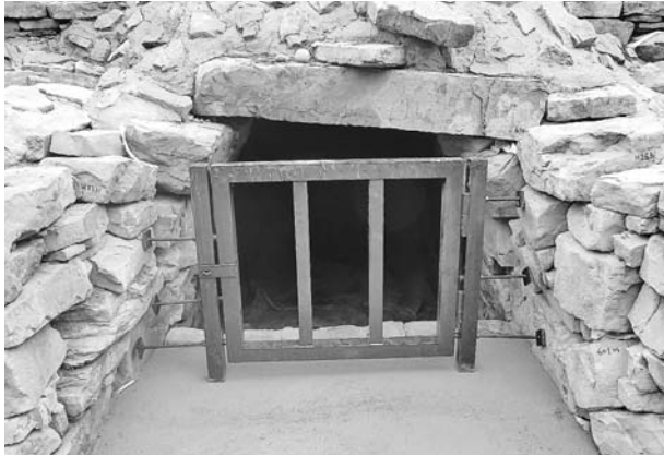
写真405 平成25年度墳丘整備工遺構保護工人止柵設置状況（南から）
