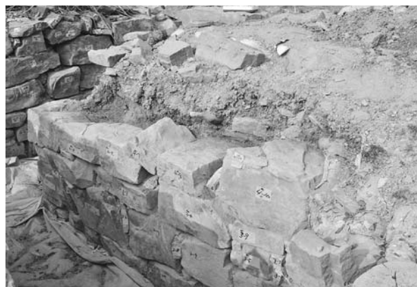
写真148 平成19年度石室修理工2号墳羨道東側壁解体状況⑨
