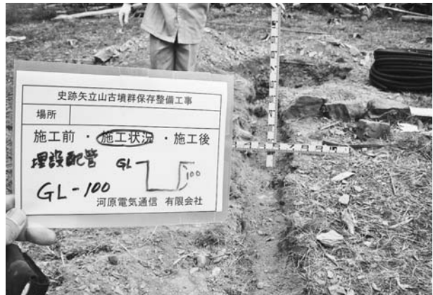
写真278 平成24年度照明施設工期中管理設掘削状況①
