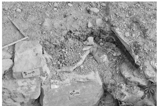
写真140 平成19年度石室修理工 2号墳羨道東側壁解体状況①
