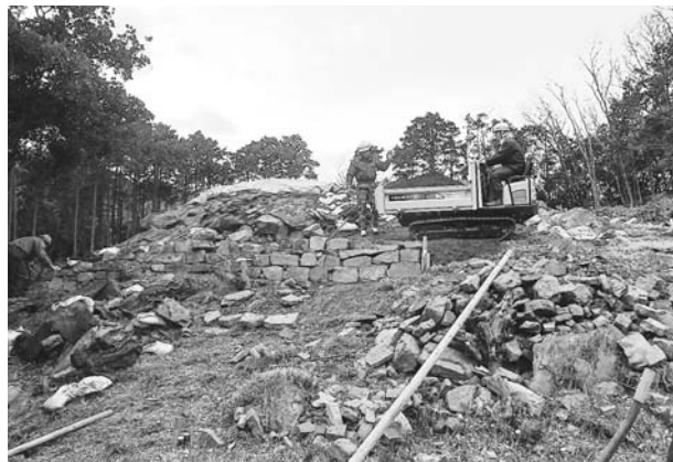
写真378 平成25年度墳丘整備工土留石積施工状況（東から）
