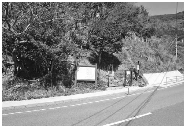
写真441 案内板及び門扉施工完了状況
