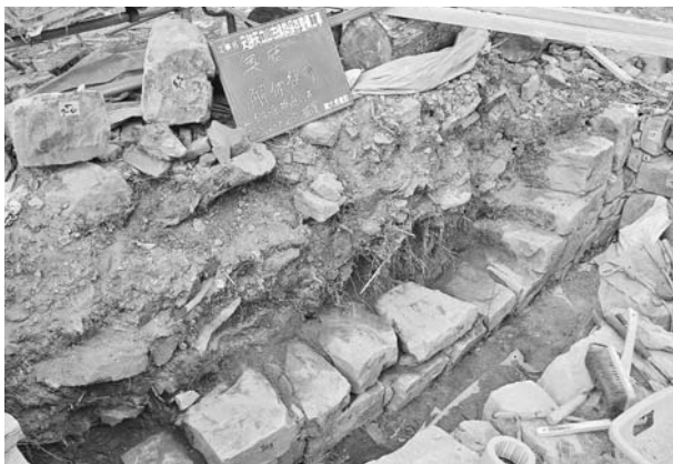
写真67 平成19年度石室修理工 2号墳奥壁解体状況⑬
