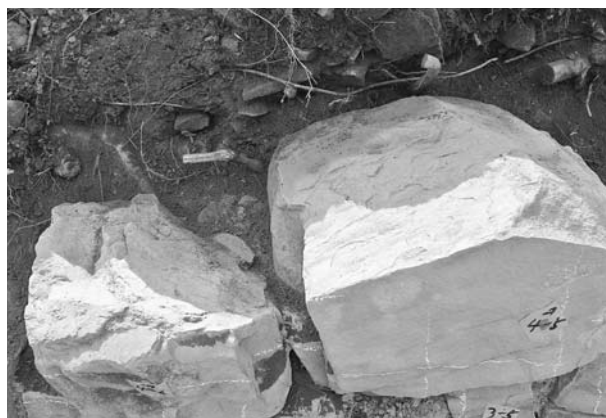
写真112 平成19年度石室修理工 2号墳羨道西側壁解体状況⑰
