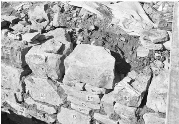
写真81 平成19年度石室修理工2号墳奥壁積み直し状況⑩
