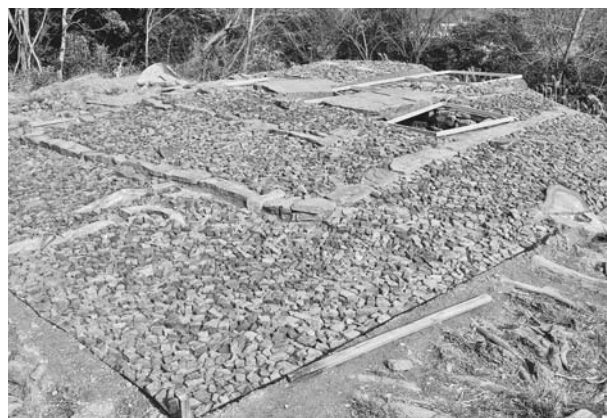
写真192 平成20年度 2号墳墳丘整備工平坦面表示完成状況(西から)
