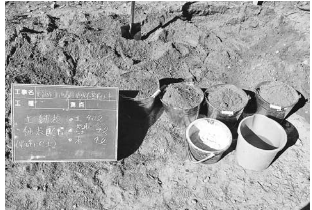
写真240 平成22年度園路広場工土舗装配合比率
