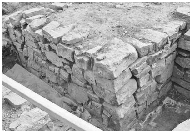
写真128 平成19年度石室修理工 2号墳羨道西側壁積み直し完了状況② (北から)
