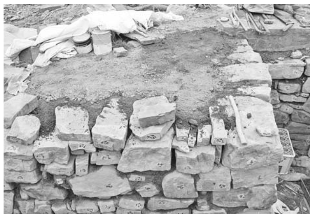
写真124 平成19年度石室修理工 2号墳羨道西側壁積み直し状況②
