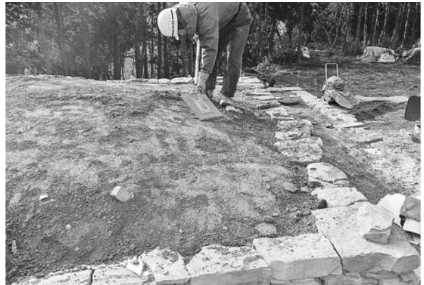
写真394 平成25年度墳丘整備工墳頂部復元盛土転圧状況（北から）
