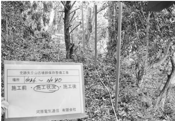
写真273 平成24年度安全管理施設工ネットフェンス施工状況
