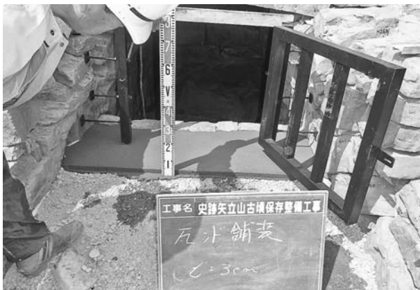
写真403 平成25年度墳丘整備工遺構保護工土舗装施工状況（南から）
