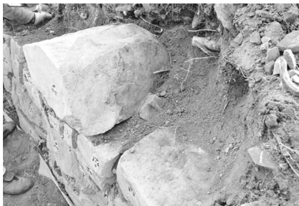
写真113 平成19年度石室修理工 2号墳羨道西側壁解体状況⑱
