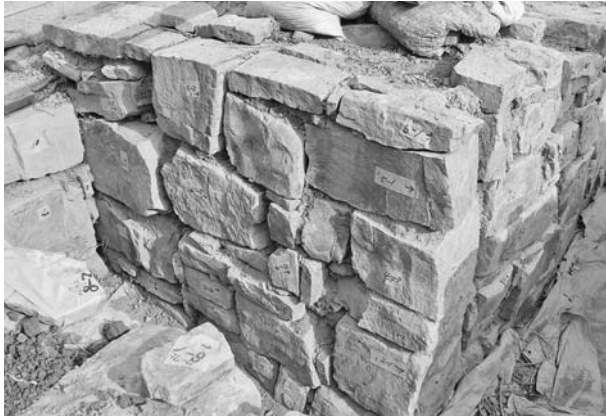
写真167 平成19年度石室修理工2号墳東前壁積み直し完了状況①(西から)
