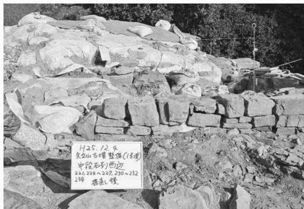
写真362 平成25年度1号墳整備作業221、224~227、230~232、234据え直し後(中段石列西辺)
