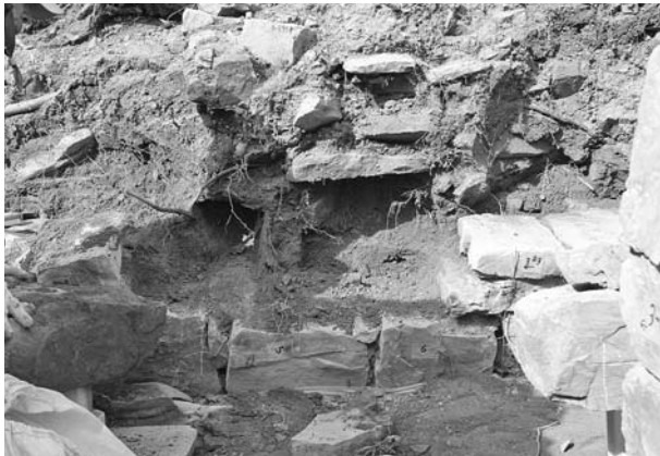
写真65 平成19年度石室修理工 2号墳奥壁解体状況⑪
