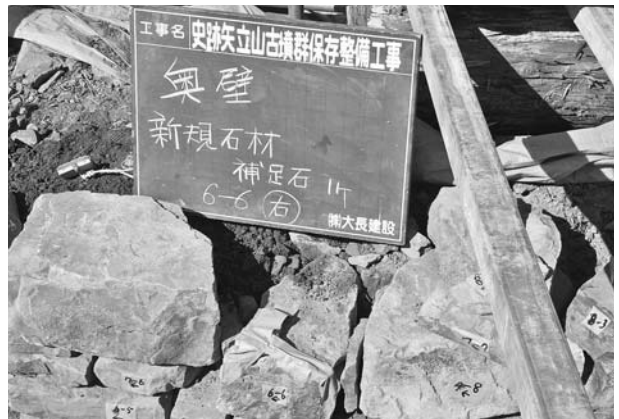
写真82 平成19年度石室修理工2号墳奥壁積み直し状況⑪
