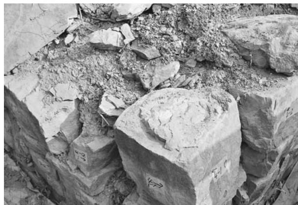
写真146 平成19年度石室修理工2号墳羨道東側壁解体状況⑦
