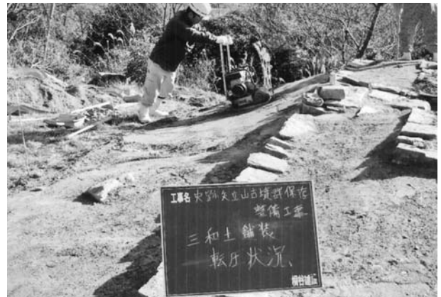
写真188 平成20年度 2号墳墳丘整備工三和土舗装転圧状況 (北西から)
