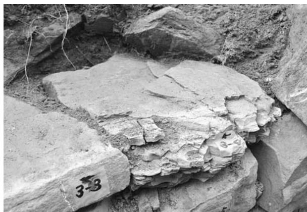
写真60 平成19年度石室修理工 2号墳奥壁解体状況⑥
