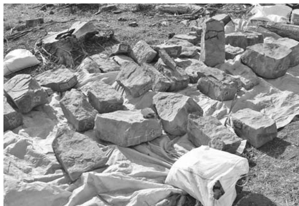
写真122 平成19年度石室修理工 2号墳羨道西側壁解体石材
