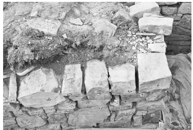
写真100 平成19年度石室修理工 2号墳羨道西側壁解体状況⑤
