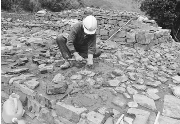
写真397 平成25年度墳丘整備工断面復元礫敷き及び目地詰め状況（南西から）
