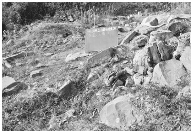
写真132 平成19年度石室修理工 2号墳前庭部西側施工前状況 (北東から)
