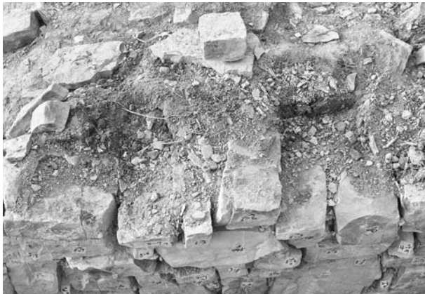
写真97 平成19年度石室修理工 2号墳羨道西側壁解体状況②
