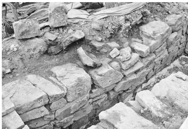
写真57 平成19年度石室修理工 2号墳奥壁解体状況③
