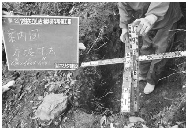
写真427 平成26年度整備工事学習施設案内図床掘り状況
