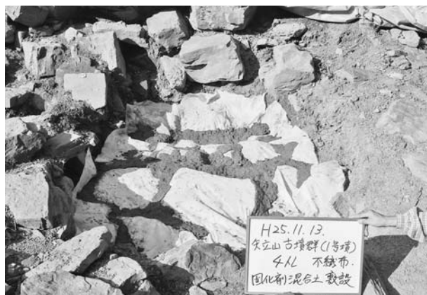
写真334 平成25年度1号墳整備作業4トレンヂ東不織布及び固化剤混合土敷設状況
