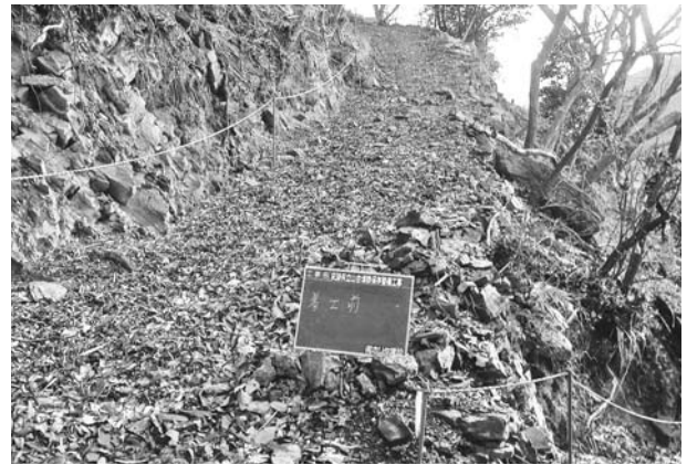
写真422 平成26年度整備工事園路施工前
