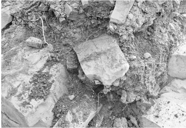
写真157 平成19年度石室修理工 2号墳羨道東側壁解体状況⑱
