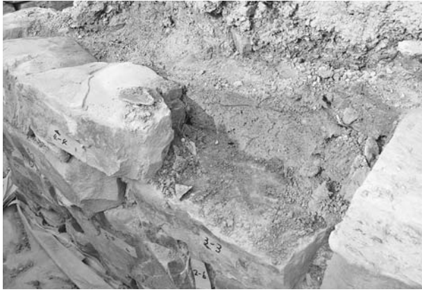
写真149 平成19年度石室修理工 2号墳羨道東側壁解体状況⑩
