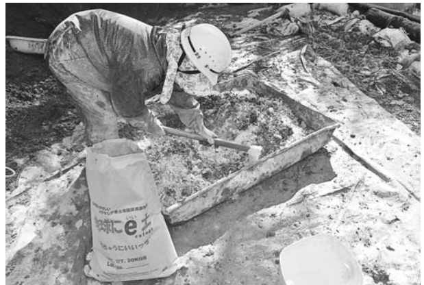
写真396 平成25年度墳丘整備工土舗装固化剤練り混ぜ状況
