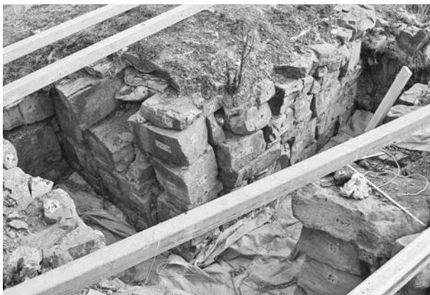
写真139 平成19年度石室修理工 2号墳羨道東側壁施工前状況③ (西から)
