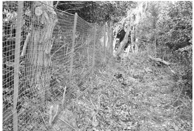
写真274 平成24年度安全管理施設工ネットフェンス設置状況
