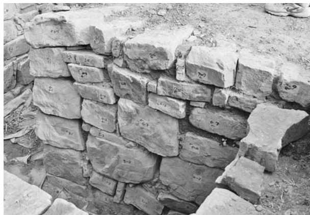
写真126 平成19年度石室修理工 2号墳西前壁積み直し完了状況 (西から)
