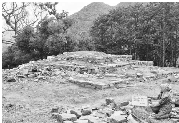
写真371 平成25年度1号墳整備作業石積み・覆土完了状況（墳丘北西部）
