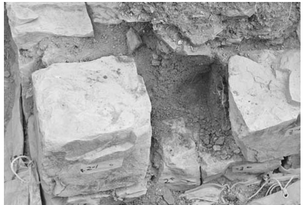
写真156 平成19年度石室修理工 2号墳羨道東側壁解体状況⑰
