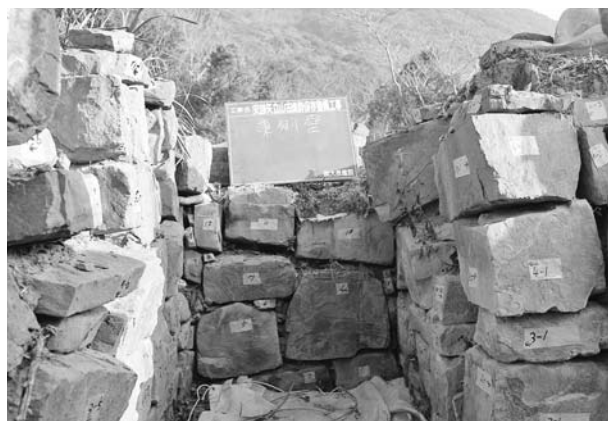
写真54 平成19年度石室修理工 2号墳東側壁施工前 (南西から)
