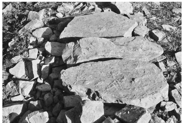
写真36 平成18年度遺構整備工 3号墳天井石据付施工後
