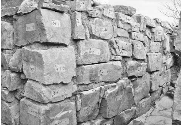
写真165 平成19年度石室修理工2号墳羨道東側壁積み直し完了状況①(西から)
