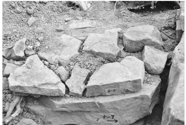
写真154 平成19年度石室修理工 2号墳羨道東側壁解体状況⑮
