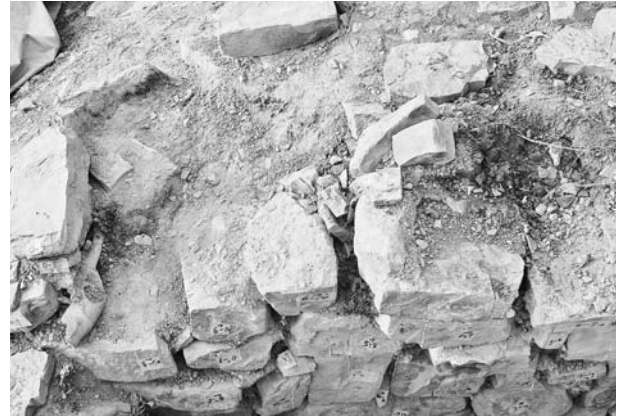
写真96 平成19年度石室修理工 2号墳羨道西側壁解体状況①
