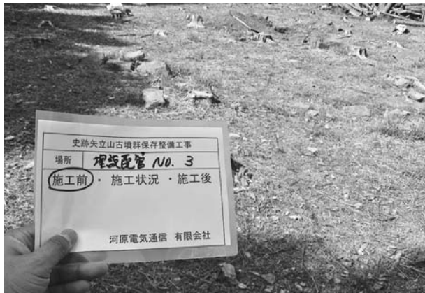
写真277 平成24年度照明施設工期中管理設施工前状況② (東から)
