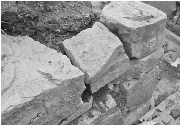
写真161 平成19年度石室修理工 2号墳羨道東側壁積み直し状況②
