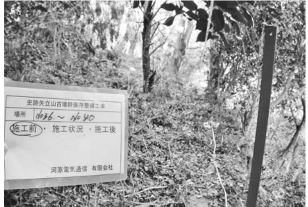
写真272 平成24年度安全管理施設工施工前状況
