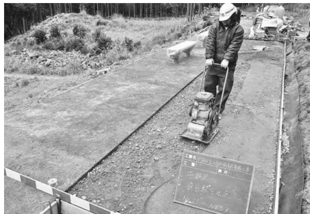
写真230 平成22年度園路広場工基礎碎石転圧状況（北東から）
