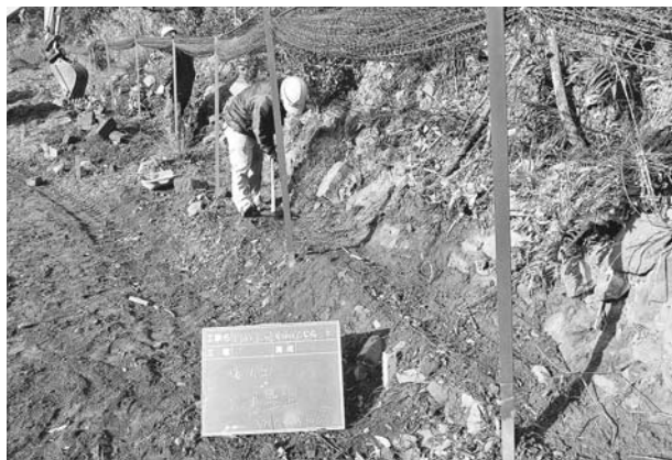
写真235 平成22年度雨水排水工蛇籠下地整正状況（東から）
