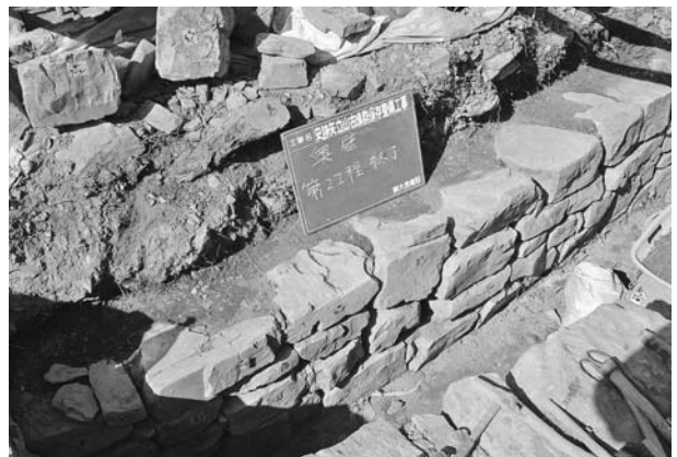
写真76 平成19年度石室修理工 2号墳奥壁積み直し状況⑤
