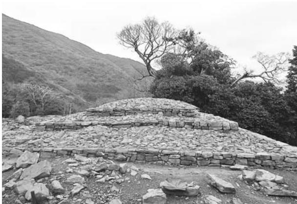
写真409 平成25年度墳丘整備工完成状況④（西から）
