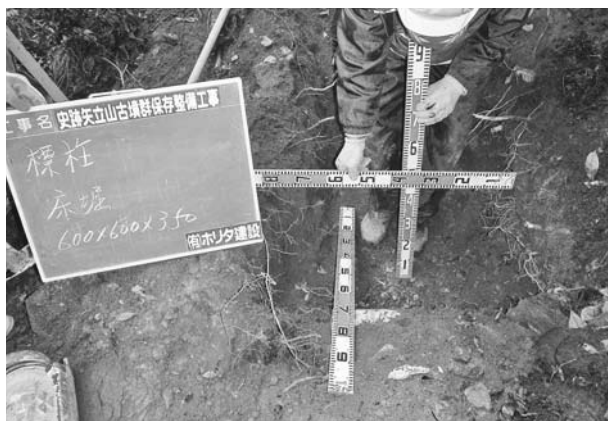
写真429 平成26年度整備工事学習施設工標柱床掘状況
