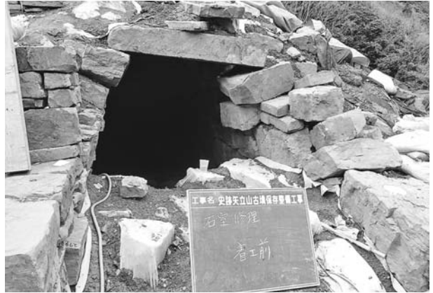
写真382 平成25年度墳丘整備工石室修理施工前状況(南から)
