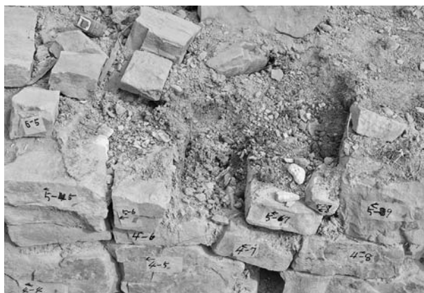
写真141 平成19年度石室修理工2号墳羨道東側壁解体状況②
