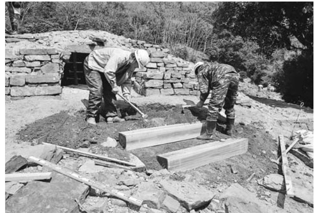
写真402 平成25年度墳丘整備工遺構保護工枕木階段設置状況（南西から）
