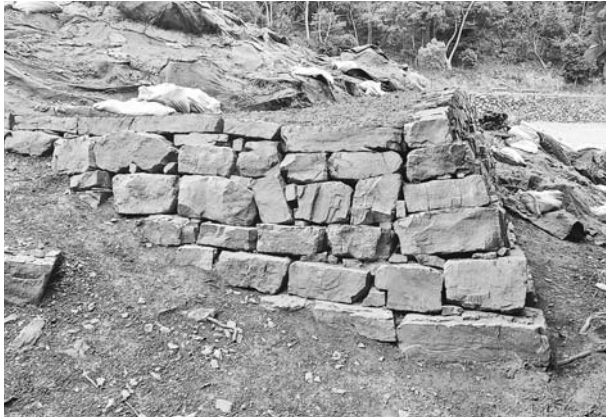
写真381 平成25年度墳丘整備工土留石積出来形(南から)
