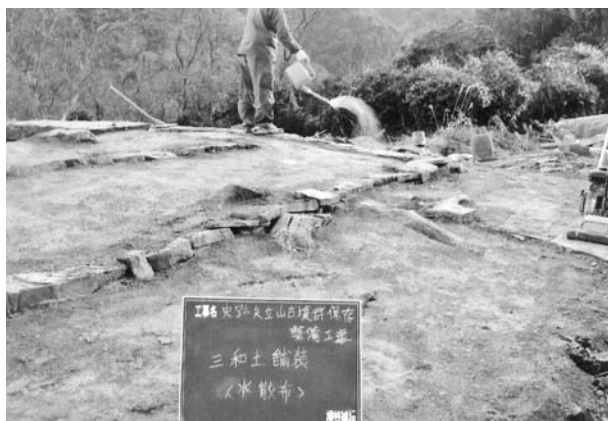
写真189 平成20年度 2号墳墳丘整備工三和土散布状況(北から)
