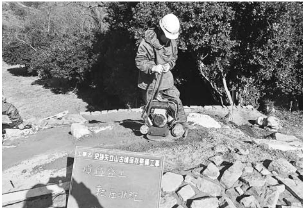
写真393 平成25年度墳丘整備工墳丘盛土盛土転圧状況（西から）
