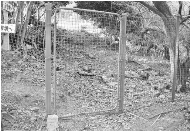
写真275 平成24年度安全管理施設工ネットフェンス設置状況(出入口)
