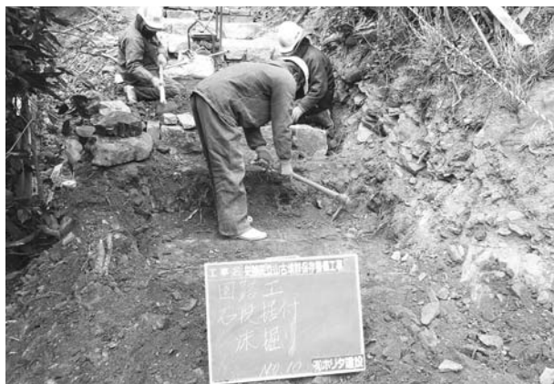
写真433 平成26年度整備工事園路工石段据付床掘状況
