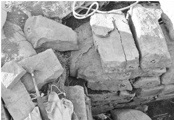
写真79 平成19年度石室修理工2号墳奥壁積み直し状況⑧
