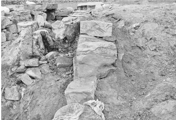
写真135 平成19年度石室修理工 2号墳前庭部東側積み直し完了状況② (南東から)
