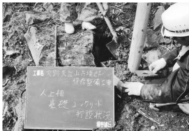
写真198 平成20年度 2号墳墳丘整備工人止柵基礎打設状況 (南東から)
