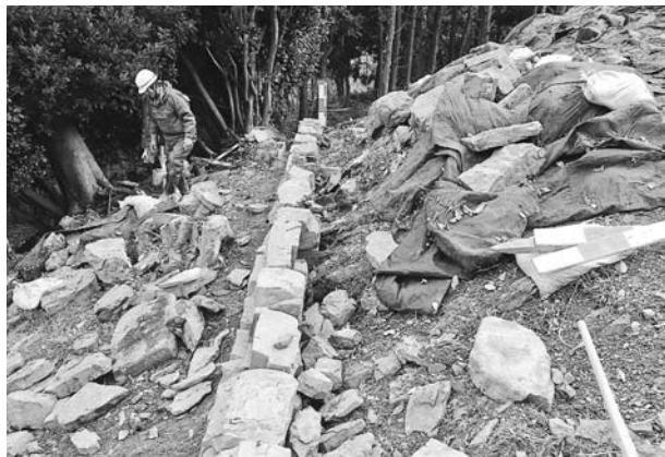
写真377 平成25年度墳丘整備工土留石積施工状況（北から）
