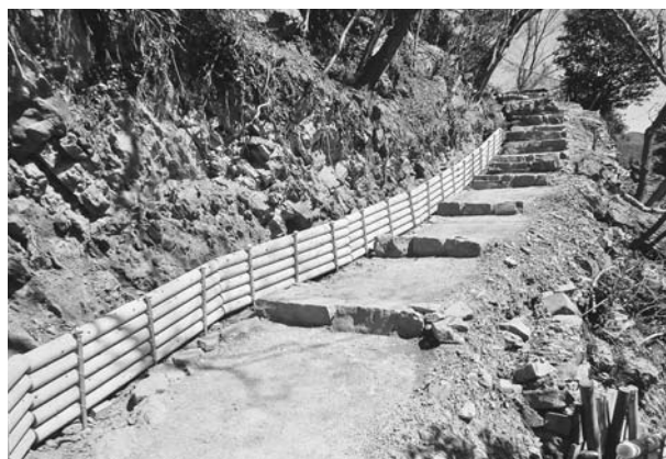
写真440 園路石段据付、土舗装及び落石防止柵施工完了状況
