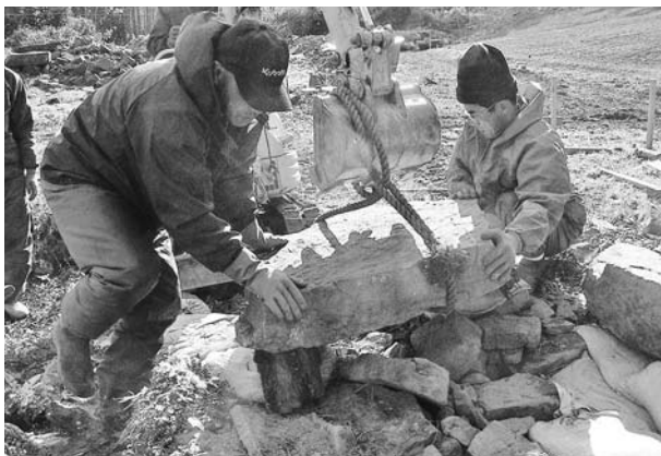
写真35 平成18年度遺構整備工 3号墳天井石据付施工状況
