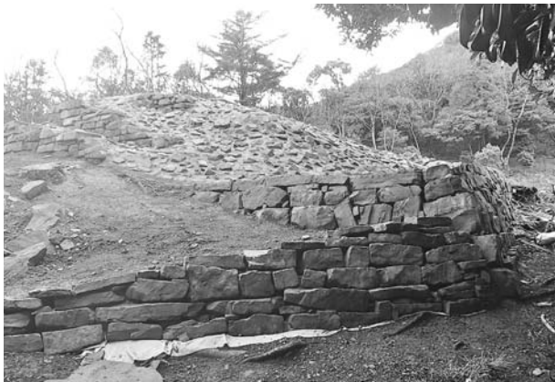
写真407 平成25年度墳丘整備工完成状況②（南東から）
