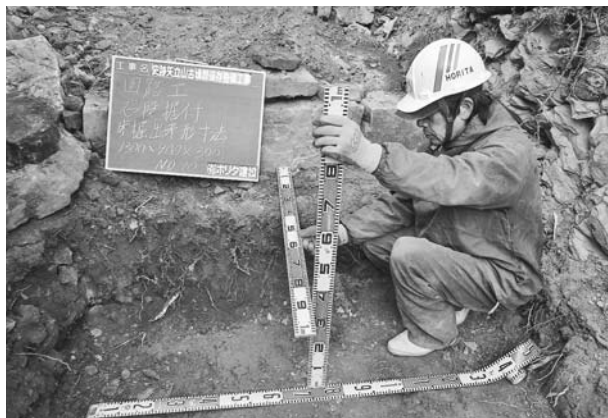
写真435 平成26年度整備工事園路工石段据付床掘出来形
