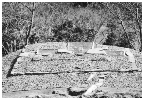
写真194 平成20年度 2号墳石室保護工フェンス設置状況②(北西から)
