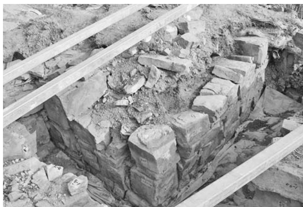
写真147 平成19年度石室修理工2号墳羨道東側壁解体状況⑧
