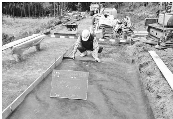
写真228 平成22年度園路広場工防草シート敷設状況(北東から)
