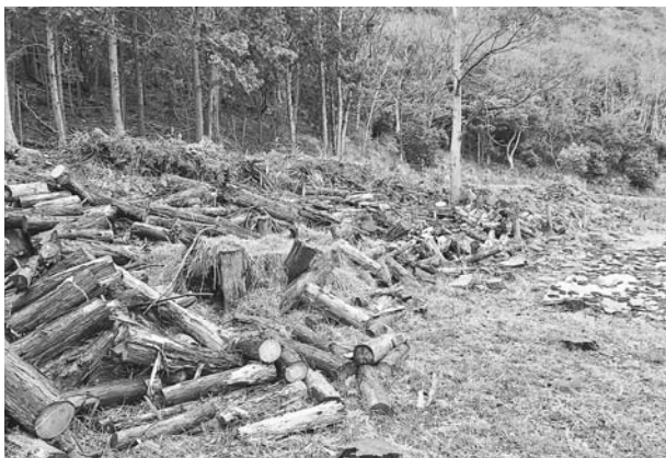
写真411 平成25年度撤去工伐採木処理施工前状況（南西から）
