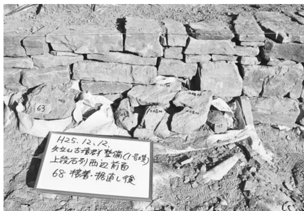
写真366 平成25年度1号墳整備作業68接着据え直し後（上段石列西边前面）
