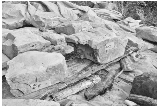
写真164 平成19年度石室修理工 2号墳羨道東側壁石材接着状況②
