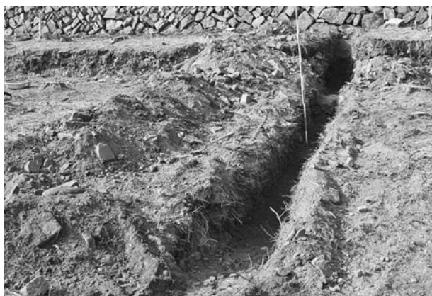
写真39 平成18年度基盤整備工造成工掘削状況
