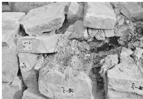
写真142 平成19年度石室修理工2号墳羨道東側壁解体状況③
