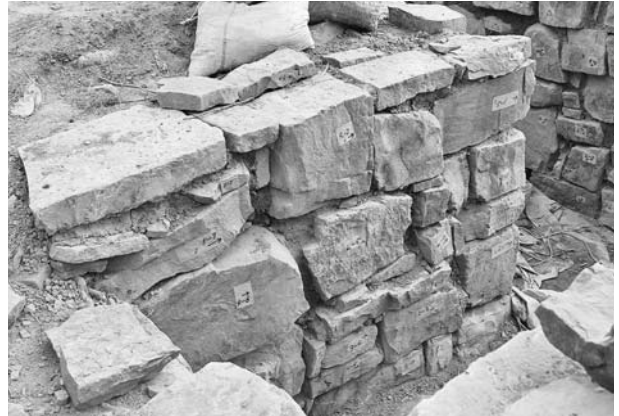
写真168 平成19年度石室修理工2号墳東前壁積み直し完了状況②(北から)
