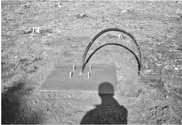
写真269 平成24年度照明施設工ソーラー設備基礎コンクリート施工状況②
