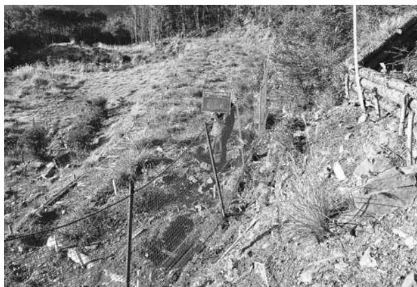
写真225 平成22年度展望広場整備工事施工前状況(北東から)
