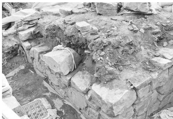
写真116 平成19年度石室修理工 2号墳羨道西側壁解体状況㉑
