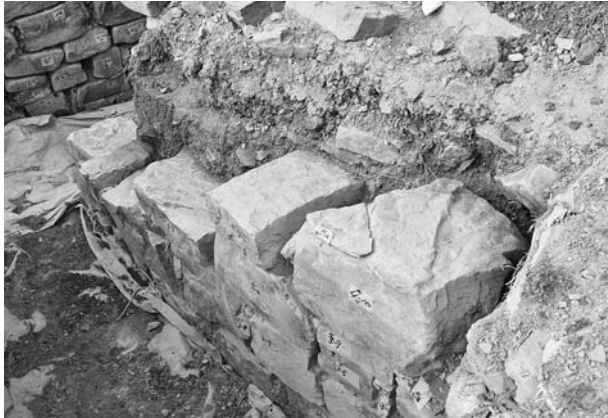
写真151 平成19年度石室修理工 2号墳羨道東側壁解体状況⑫
