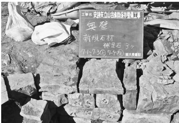
写真83 平成19年度石室修理工2号墳奥壁積み直し状況⑫
