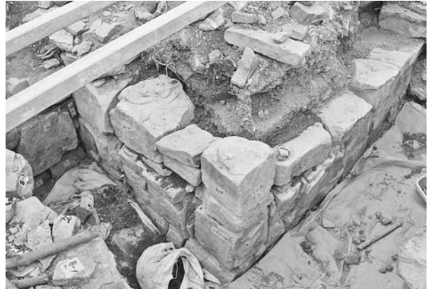
写真160 平成19年度石室修理工 2号墳羨道東側壁積み直し状況①
