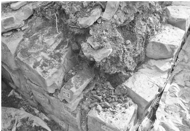
写真155 平成19年度石室修理工 2号墳羨道東側壁解体状況⑯
