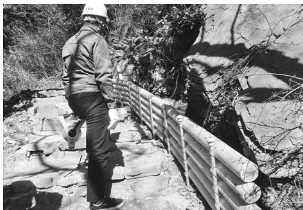
写真431 平成26年度整備工事安全管理施設工落石防止柵竣工検査状況
