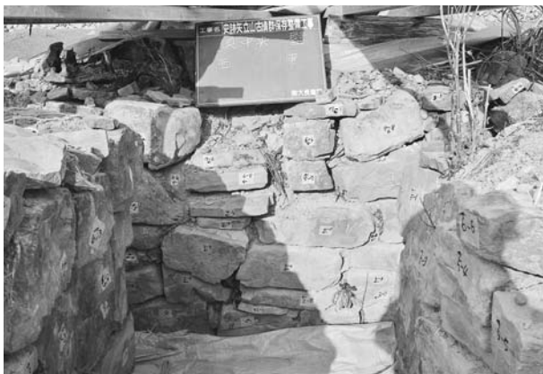
写真51 平成19年度石室修理工2号墳奥壁中央施工前(南東から)
