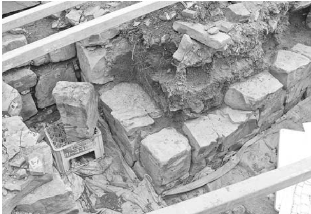
写真159 平成19年度石室修理工 2号墳羨道東側壁解体状況⑳
