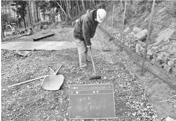
写真239 平成22年度園路広場工碎石敷施工状況 (北東から)
