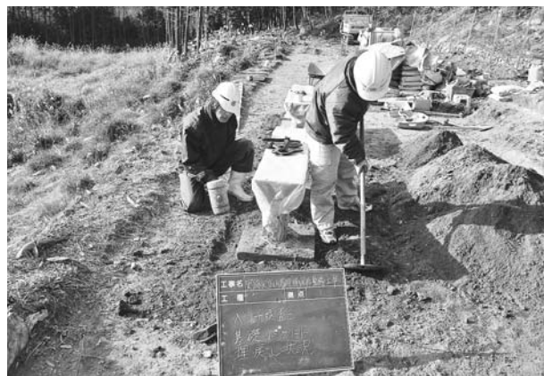
写真234 平成22年度休憩施設工ベンチ基礎埋設状況（北東から）
