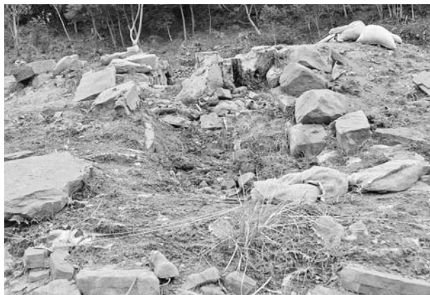
写真131 平成19年度石室修理工 2号墳前庭部施工前状況 (南東から)
