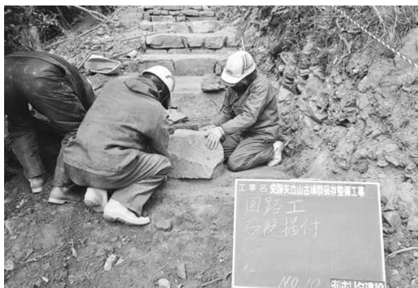
写真437 平成26年度整備工事園路工石段据付施工状況
