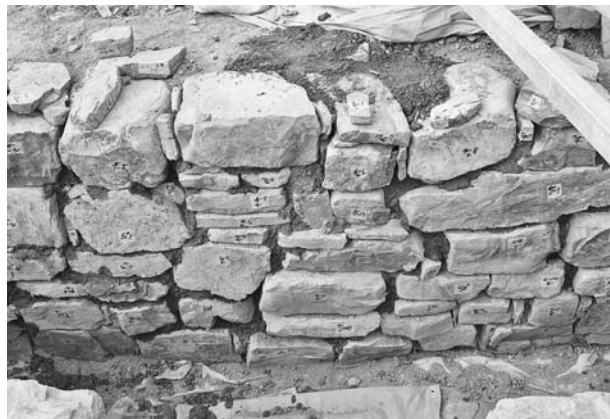
写真90 平成19年度石室修理工 2号墳奥壁積中央積み直し完了状況
