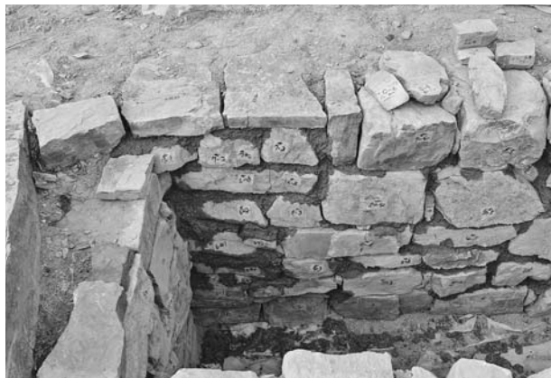
写真89 平成19年度石室修理工 2号墳奥壁西側積み直し完了状況
