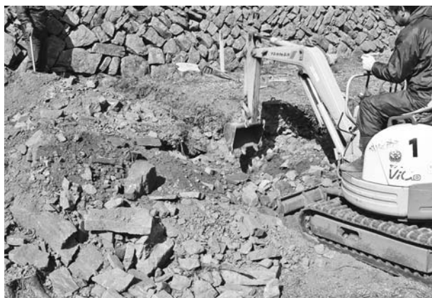
写真37 平成18年度基盤整備工造成工施工状況①
