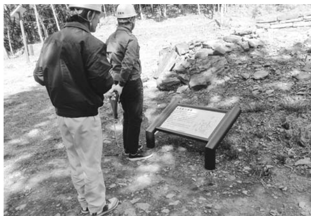
写真432 平成26年度整備工事学習施設工説明板竣工検査状況
