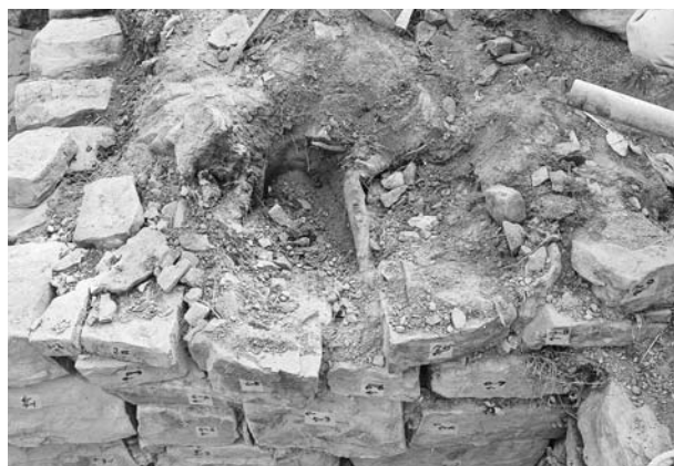
写真102 平成19年度石室修理工 2号墳羨道西側壁解体状況⑦
