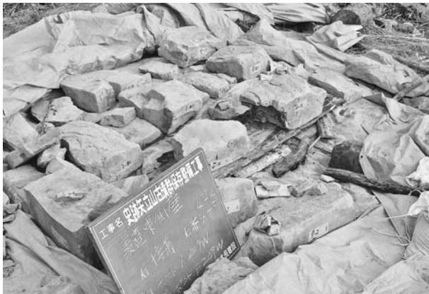
写真163 平成19年度石室修理工 2号墳羨道東側壁石材接着状況①
