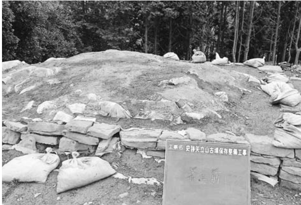
写真391 平成25年度墳丘整備工墳頂部復元施工前状況（北から）
