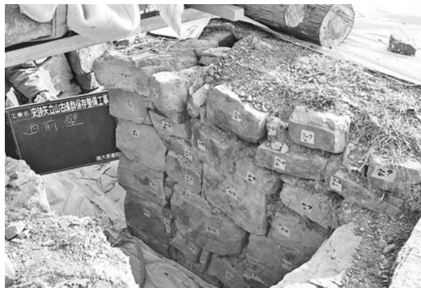
写真92 平成19年度石室修理工 2号墳西前壁施工前 (西から)
