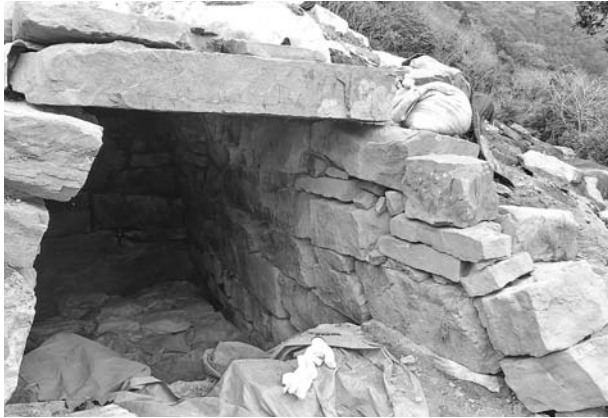
写真389 平成25年度墳丘整備工石室修理完成状況（南から）
