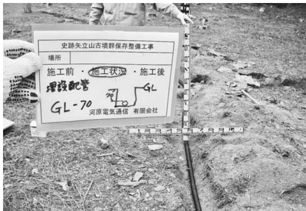
写真279 平成24年度照明施設工期中管理設掘削状況②
