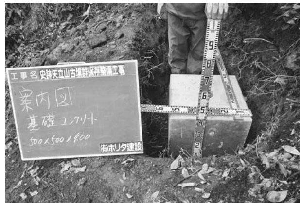
写真428 平成26年度整備工事学習施設案内図基礎コンクリート
