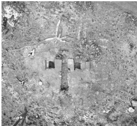
写真15 2号墳整備前状況(平成19年3月8日撮影)
