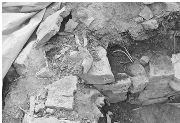
写真119 平成19年度石室修理工 2号墳羨道西側壁解体状況④
