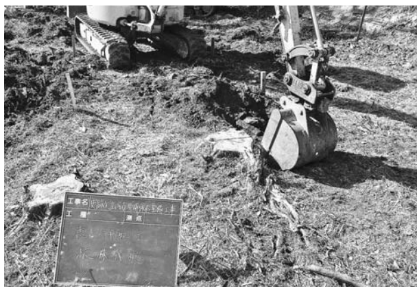
写真227 平成22年度土工抜状況(北東から)
