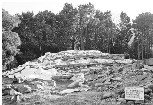
写真368 平成25年度1号墳整備作業石積み完了・不織布・固化剤混合土敷設状況（墳丘北部）
