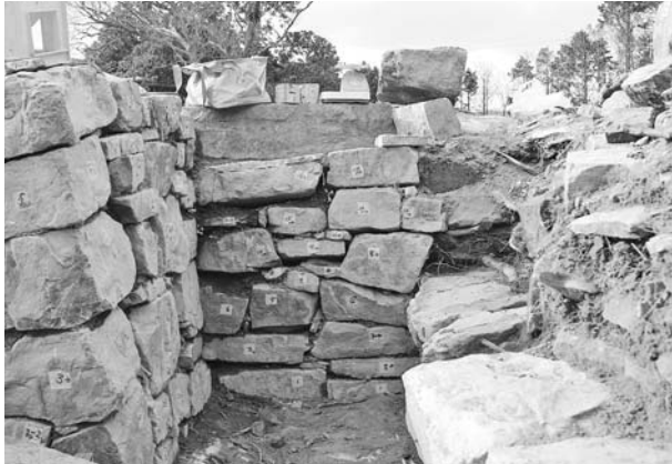
写真63 平成19年度石室修理工 2号墳奥壁解体状況⑨
