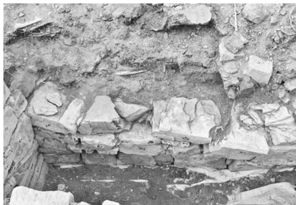
写真58 平成19年度石室修理工 2号墳奥壁解体状況④
