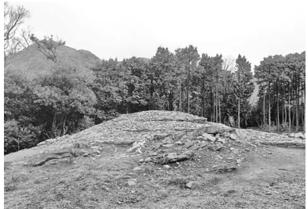
写真410 平成25年度墳丘整備工完成状況⑤（北から）
