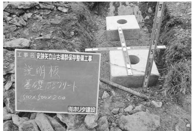
写真426 平成26年度整備工事学習施設工説明板基礎コンクリート
