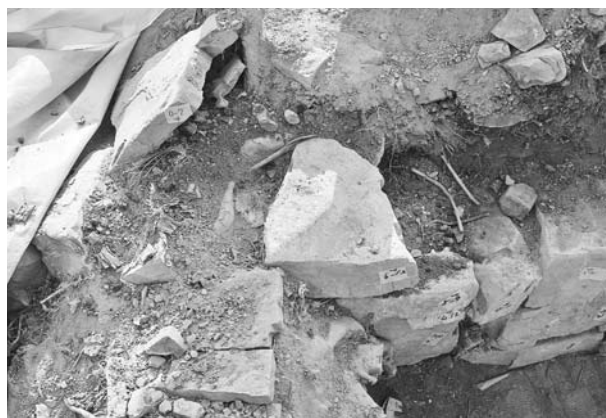
写真120 平成19年度石室修理工 2号墳羨道西側壁解体状況⑤
