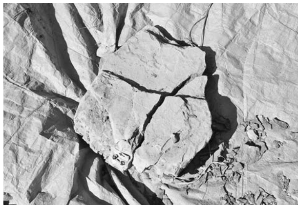
写真86 平成19年度石室修理工 2号墳奥壁破碎石材③
