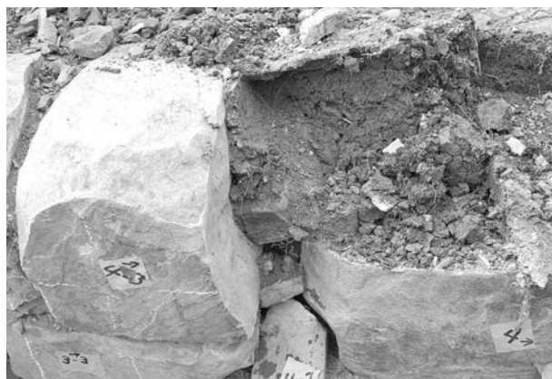
写真108 平成19年度石室修理工 2号墳羨道西側壁解体状況⑬
