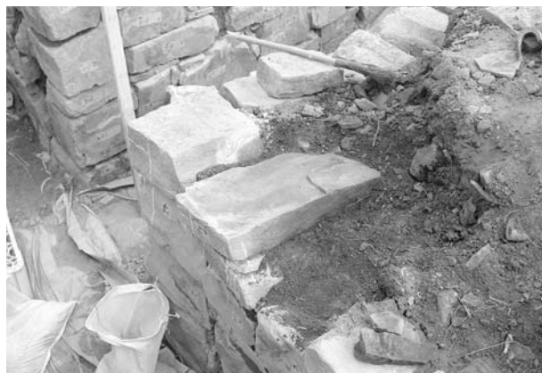
写真106 平成19年度石室修理工 2号墳羨道西側壁解体状況⑪
