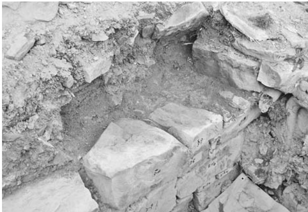
写真153 平成19年度石室修理工 2号墳羨道東側壁解体状況⑭
