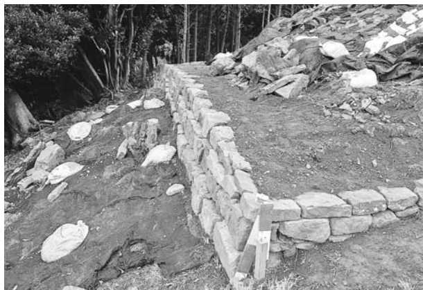
写真379 平成25年度墳丘整備工土留石積出来形（北から）
