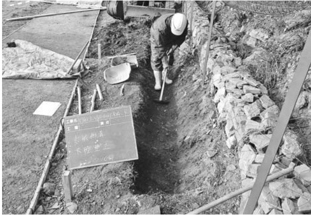
写真237 平成22年度雨水排水工素掘側溝不陸整正状況 (北東から)
