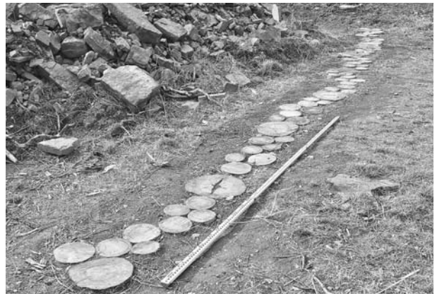
写真172 平成19年度園路工踏み板完成状況
