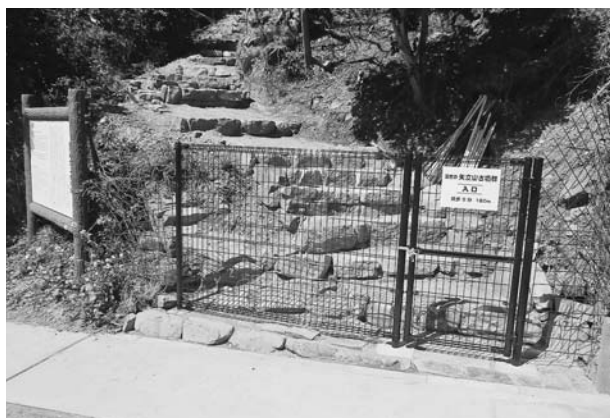
写真443 園路入口門扉設置完了状況
