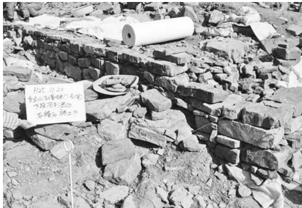
写真349 平成25年度1号墳整備作業石積み施工状況 (下段石列西辺)
