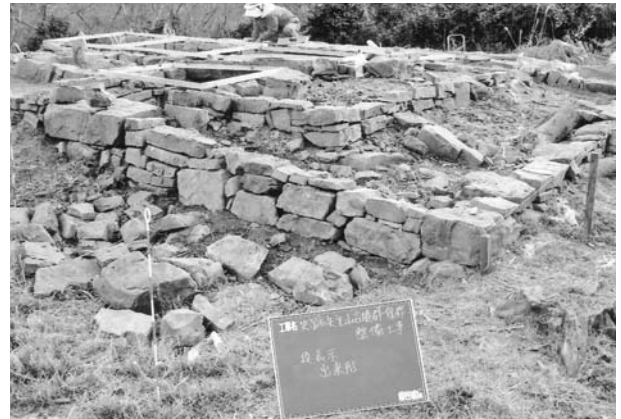
写真186 平成20年度 2号墳墳丘整備工段表示出来形① (北から)
