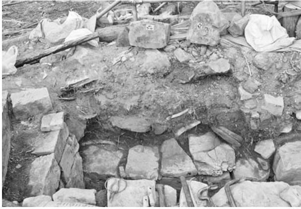
写真61 平成19年度石室修理工 2号墳奥壁解体状況⑦
