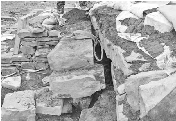
写真387 平成25年度墳丘整備工石室修理施工状況(東から)
