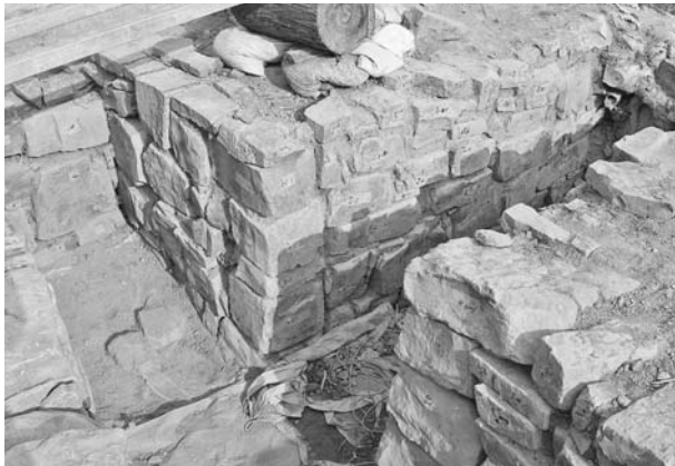
写真169 平成19年度石室修理工2号墳羨道東側壁及び東前壁積み直し完了状況③(西から)
