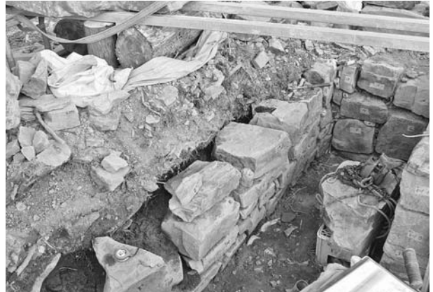
写真72 平成19年度石室修理工 2号墳奥壁積み直し状況①
