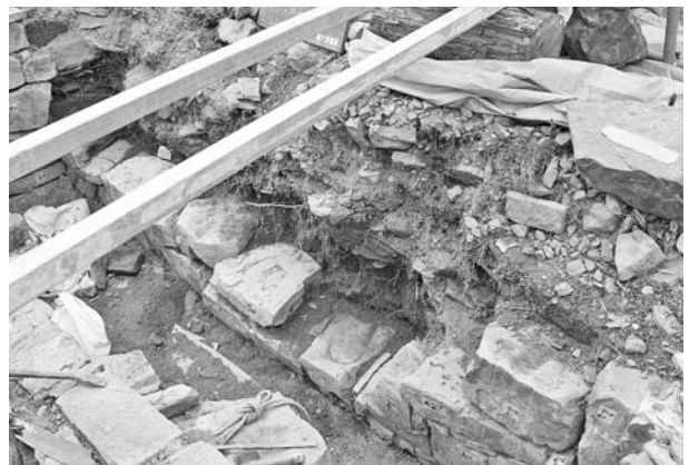
写真68 平成19年度石室修理工 2号墳奥壁解体状況⑭
