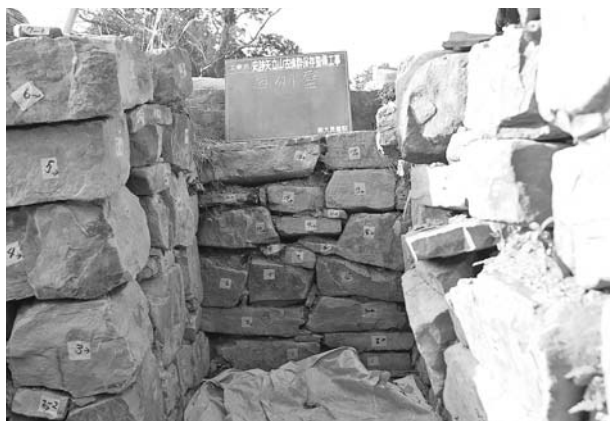
写真53 平成19年度石室修理工 2号墳西側壁施工前 (北東から)
