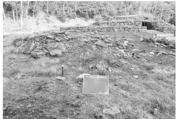
写真424 平成26年度整備工事学習施設工説明板施工前
