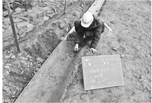
写真238 平成22年度雨水排水工素掘側溝土舗装状況 (南西から)
