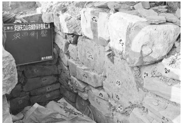
写真50 平成19年度石室修理工2号墳奥壁西側施工前(東から)
