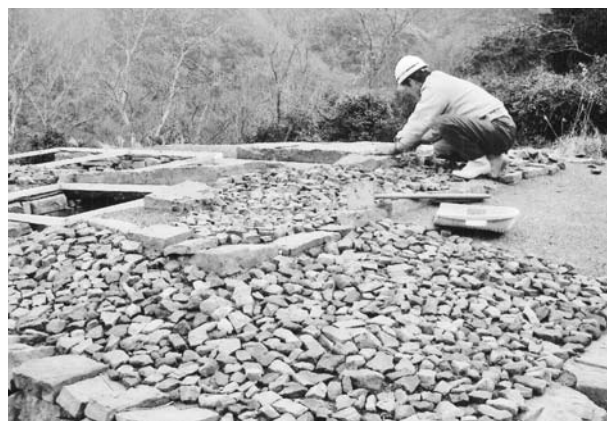
写真190 平成20年度 2号墳墳丘整備工平坦面表示石材敷設状況(北から)
