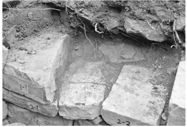
写真70 平成19年度石室修理工 2号墳奥壁解体状況⑯
