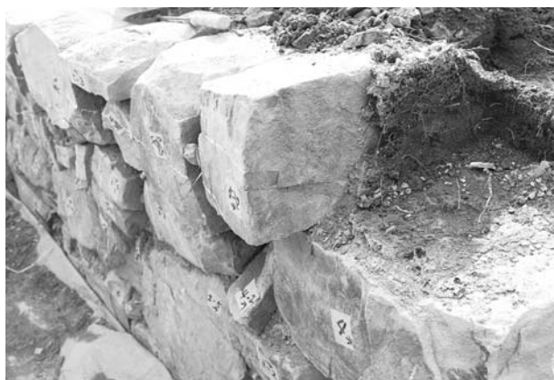
写真107 平成19年度石室修理工 2号墳羨道西側壁解体状況⑫
