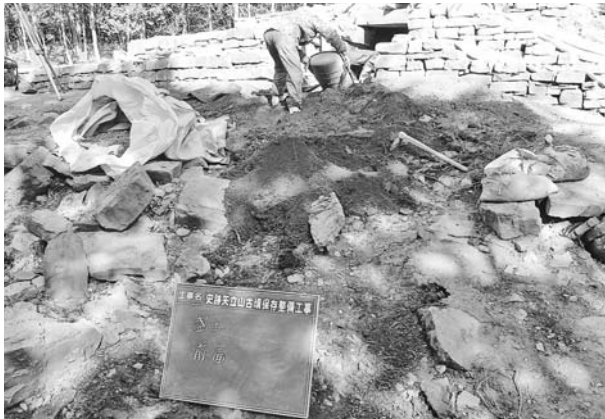
写真401 平成25年度墳丘整備工盛土敷き均し状況（南東から）
