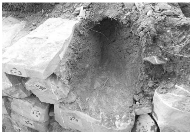
写真110 平成19年度石室修理工 2号墳羨道西側壁解体状況⑮
