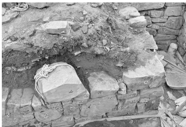
写真115 平成19年度石室修理工 2号墳羨道西側壁解体状況⑳
