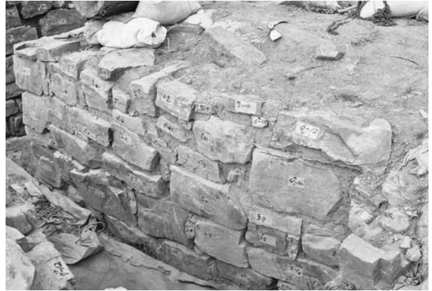
写真166 平成19年度石室修理工2号墳羨道東側壁積み直し完了状況②(南から)
