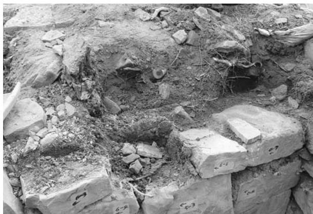
写真105 平成19年度石室修理工 2号墳羨道西側壁解体状況⑩
