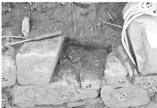
写真117 平成19年度石室修理工 2号墳羨道西側壁解体状況②
