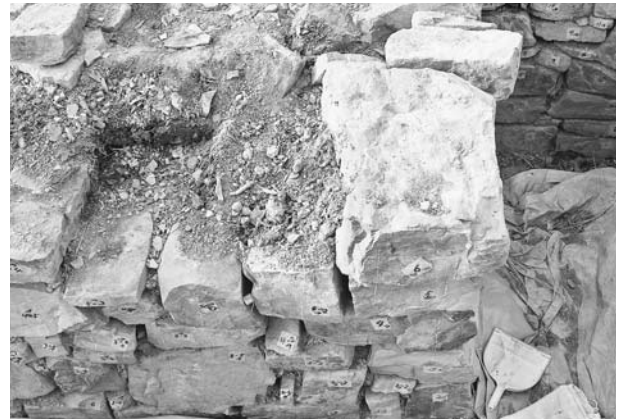
写真98 平成19年度石室修理工 2号墳羨道西側壁解体状況③
