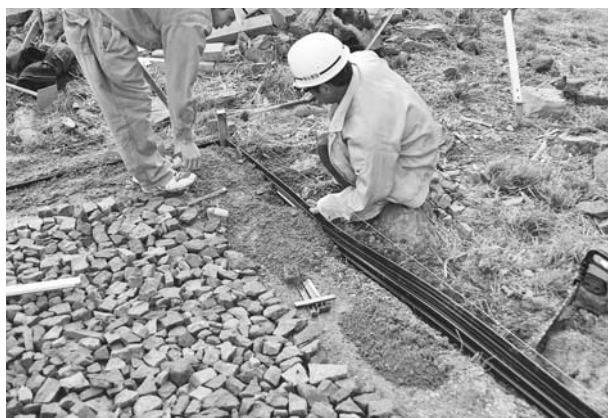
写真191 平成20年度 2号墳墳丘整備工根切り板敷設状況(北東から)
