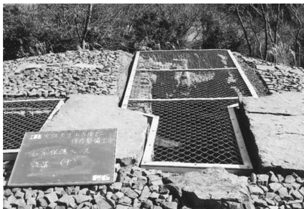
写真193 平成20年度 2号墳石室保護工フェンス設置状況①(北西から)
