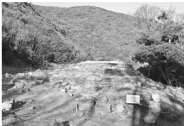
写真369 平成25年度1号墳整備作業石積み完了・不織布・固化剤混合土敷設状況（墳丘南西部）
