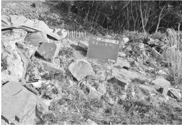
写真133 平成19年度石室修理工 2号墳前庭部東側施工前状況 (南西から)
