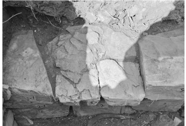
写真64 平成19年度石室修理工 2号墳奥壁解体状況⑩
