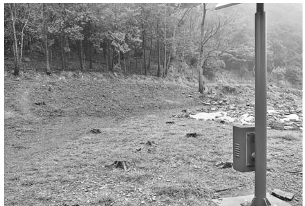
写真412 平成25年度撤去工伐採木処理完成状況（南西から）
