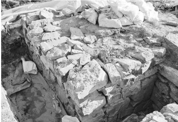
写真95 平成19年度石室修理工 2号墳羨道西側壁施工前全景 (西から)
