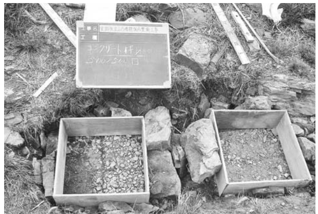
写真212 平成21年度学習施設工2号墳説明板基礎枠状況(北西から)
