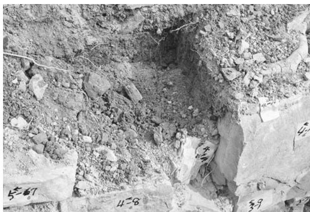
写真143 平成19年度石室修理工2号墳羨道東側壁解体状況④
