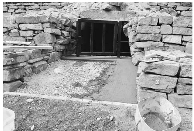
写真404 平成25年度墳丘整備工遺構保護工土舗装施工状況（南から）
