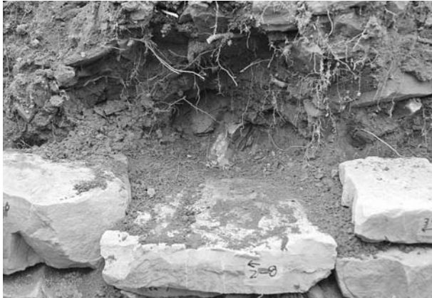
写真71 平成19年度石室修理工 2号墳奥壁解体状況⑰
