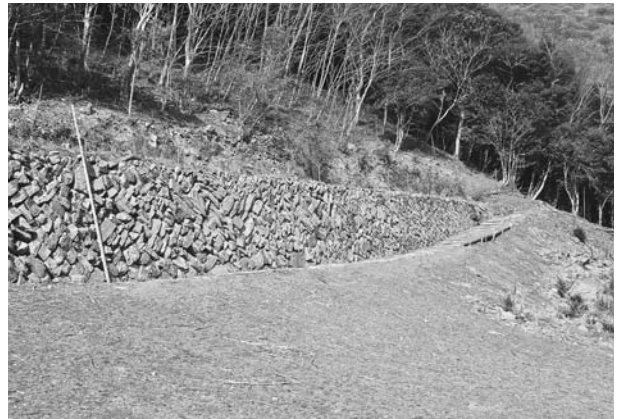
写真170 平成19年度園路工東側丸太階段完成状況
