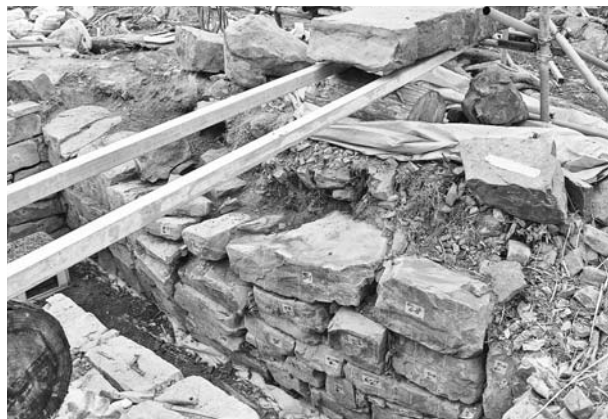
写真56 平成19年度石室修理工 2号墳奥壁解体状況②
