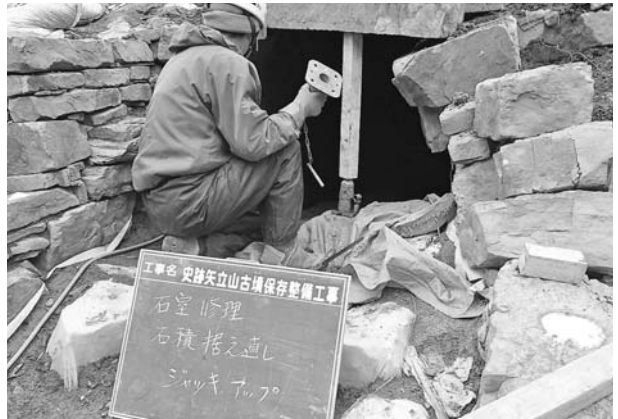
写真386 平成25年度墳丘整備工石室修理施工状況(南から)
