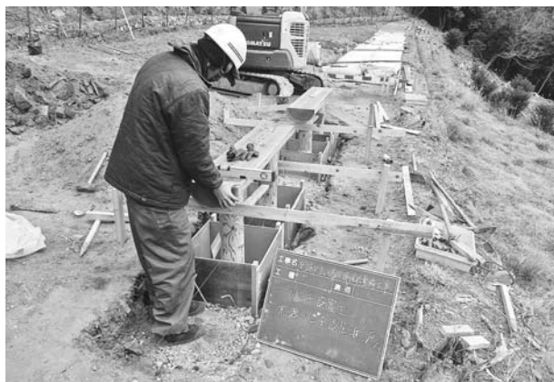
写真233 平成22年度休憩施設工ベンチ設置状況（南西から）
