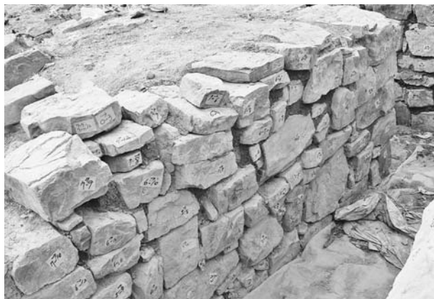
写真127 平成19年度石室修理工 2号墳羨道西側壁積み直し完了状況① (東から)
