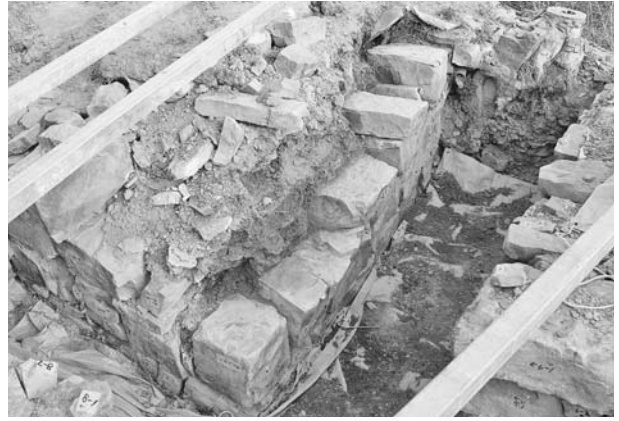
写真150 平成19年度石室修理工 2号墳羨道東側壁解体状況⑪
