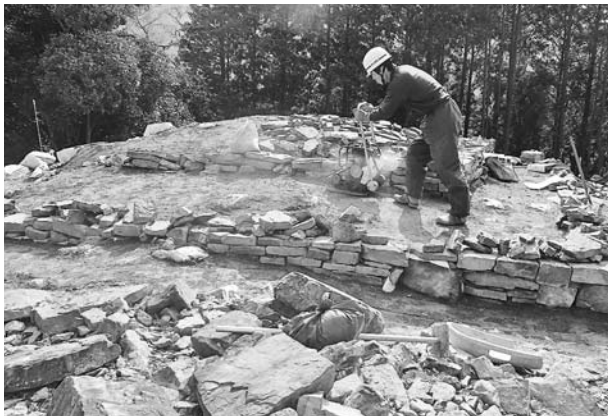
写真395 平成25年度墳丘整備工墳頂部復元盛土転圧状況（北から）
