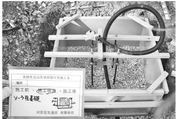
写真268 平成24年度照明施設工ソーラー設備基礎コンクリート施工状況①
