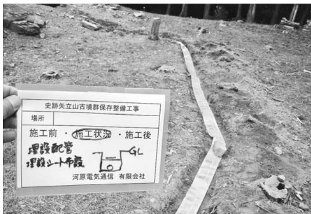
写真281 平成24年度照明施設工埋設シート敷設状況② (西から)
