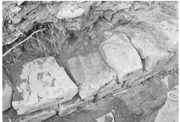
写真66 平成19年度石室修理工 2号墳奥壁解体状況⑫
