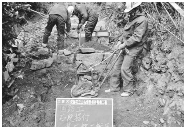
写真434 平成26年度整備工事園路工石段据付基面整正転圧状況
