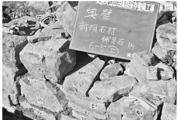
写真80 平成19年度石室修理工2号墳奥壁積み直し状況⑨
