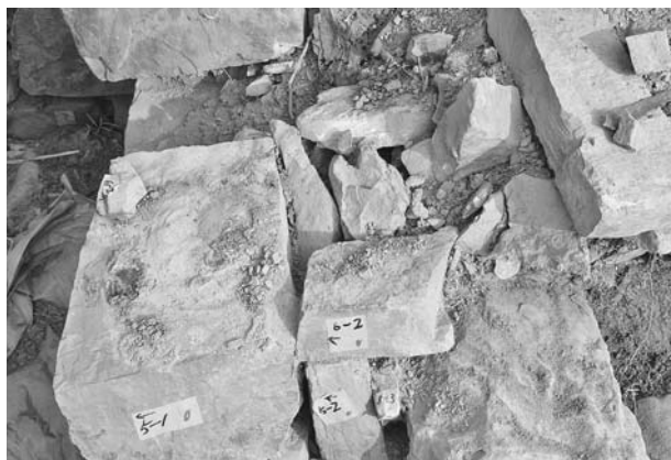
写真145 平成19年度石室修理工2号墳羨道東側壁解体状況⑥
