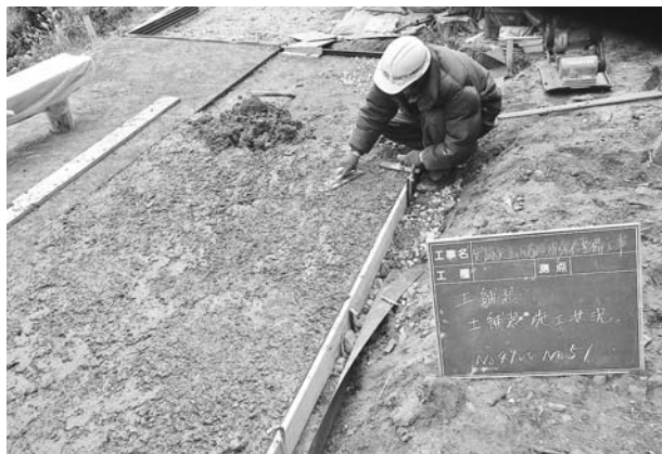
写真231 平成22年度園路広場工土舗装施工状況（北東から）
