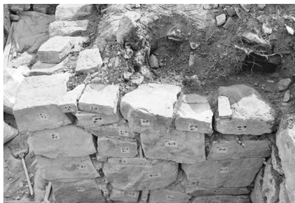
写真104 平成19年度石室修理工 2号墳羨道西側壁解体状況⑨
