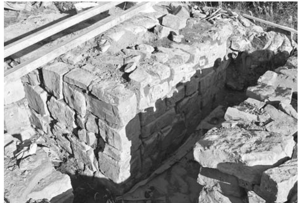
写真162 平成19年度石室修理工 2号墳羨道東側壁積み直し状況③
