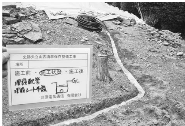
写真280 平成24年度照明施設工埋設シート敷設状況① (南西から)
