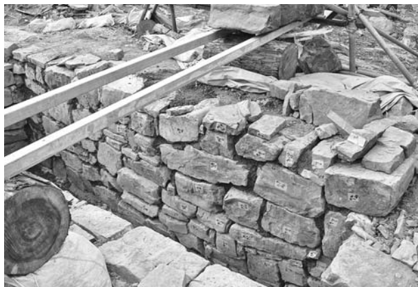
写真87 平成19年度石室修理工 平成19年度石室修理工 2号墳奥壁積直完了状況① (東から)
