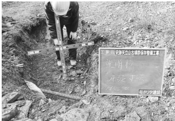
写真425 平成26年度整備工事学習施設工説明板床掘り状況
