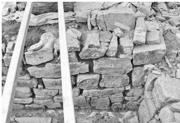
写真91 平成19年度石室修理工 2号墳奥壁東側積み直し完了状況
