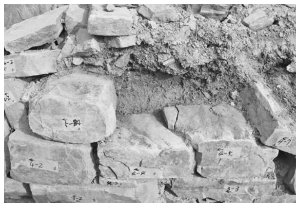
写真144 平成19年度石室修理工2号墳羨道東側壁解体状況⑤
