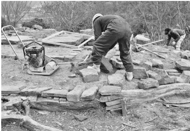
写真185 平成20年度 2号墳墳丘整備工段表示施工状況 (西から)
