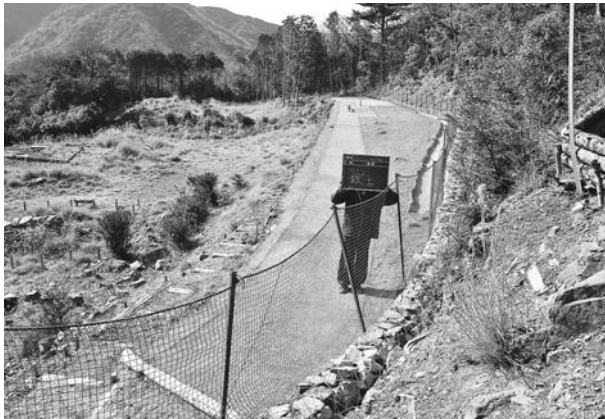
写真241 平成22年度展望広場整備工事完成状況 (南西から)
