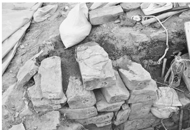
写真123 平成19年度石室修理工 2号墳羨道西側壁積み直し状況①
