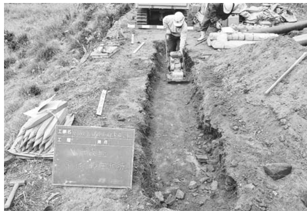
写真232 平成22年度休憩施設工床掘状況（北東から）
