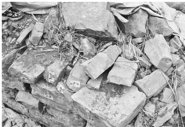
写真55 平成19年度石室修理工 2号墳奥壁解体状況①
