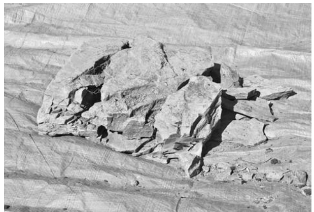
写真84 平成19年度石室修理工2号墳奥壁破碎石材①
