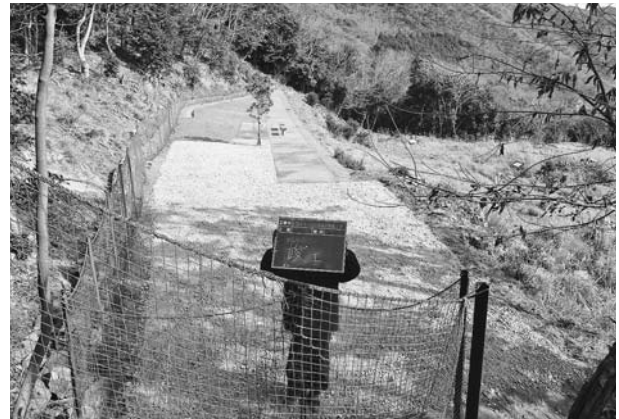
写真242 平成22年度展望広場整備工事完成状況 (北東から)
