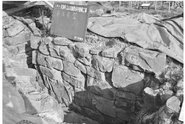
写真138 平成19年度石室修理工 2号墳羨道東側壁施工前状況② (南から)
