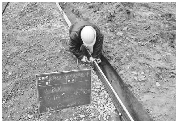
写真229 平成22年度園路広場工根切板敷設状況（北東から）
