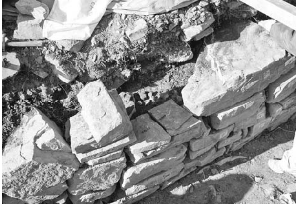
写真77 平成19年度石室修理工2号墳奥壁積み直し状況⑥
