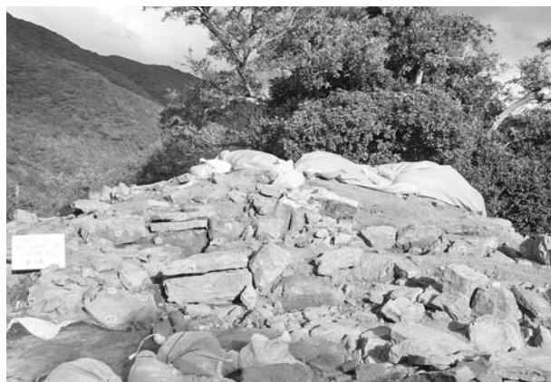
写真338 平成25年度1号墳整備作業上段石列西辺番付け後
