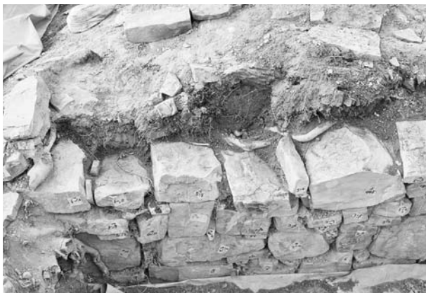
写真99 平成19年度石室修理工 2号墳羨道西側壁解体状況④
