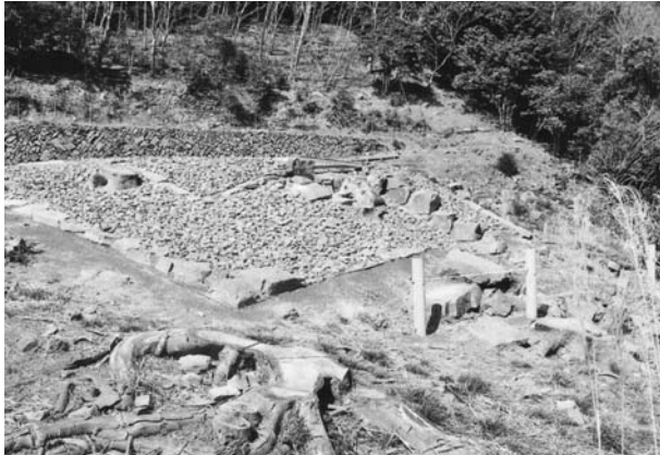
写真183 平成20年度 2号墳竣工状況② (南から)
